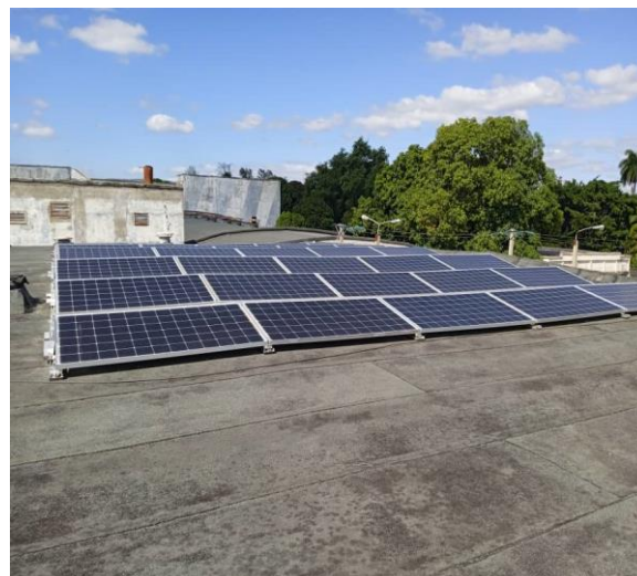
Figura 4. Parque Fotovoltaico instalado en la cubierta del Poligráfico
