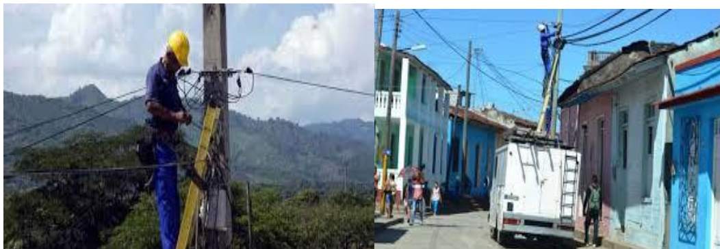
Imagen 2. Recuperación de cables post huracán.
