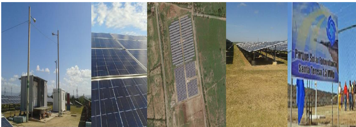
Figura: 3 Parques solares fotovoltaicos de Santa-Teresa.
